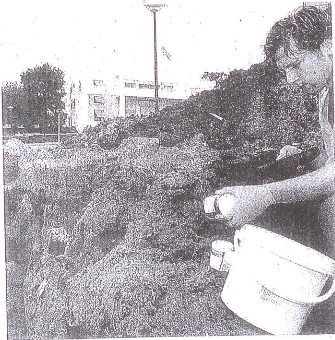
Werken aan de bodem voor het riool.
